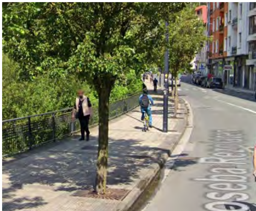
Perales en alcorque en la acera con cubrealcorque metálico.
